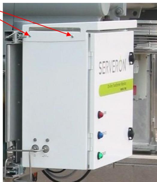
图 12 遮阳盖的安装
