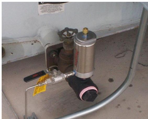
图 15 排气装置和 Serveron 回油阀
