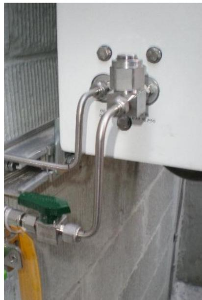
图 13 安装油过滤器
