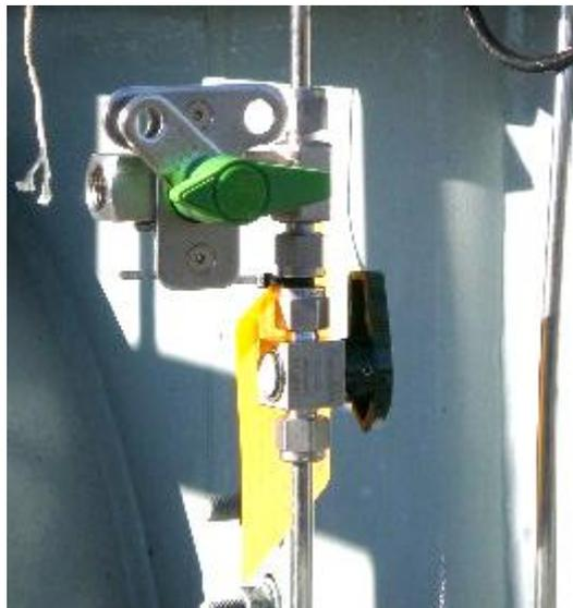
图 16 手工采样口/关闭阀
