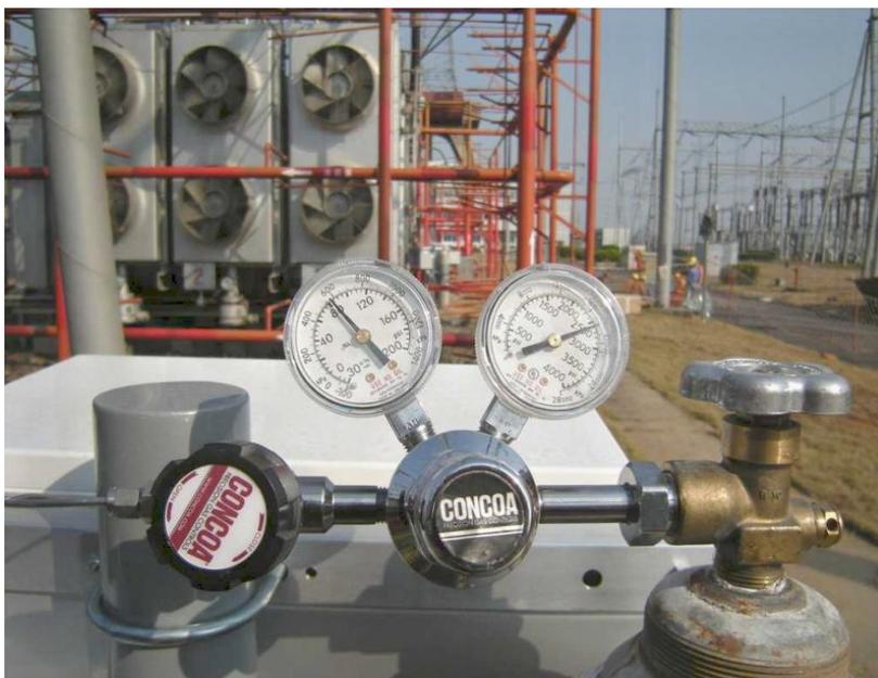
图 22 氦气减压阀
