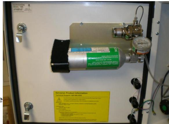
**Figure 21 : Cylindre de calibration installé**
