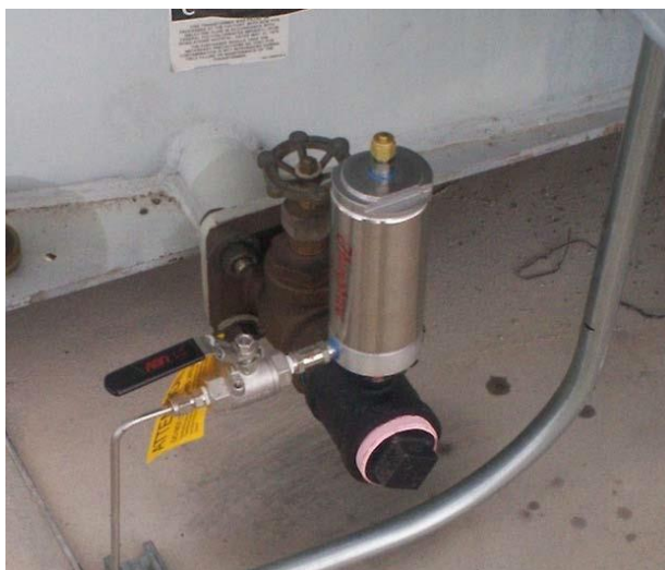
Figura 14: Dispositivo de purga y válvula Serveron de retorno de aceite
