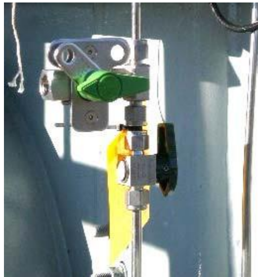
Figura 15: Puerto de muestreo / Unidad de cierre secundario
