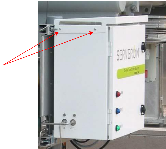
Figura 12: Montaje de parasol
